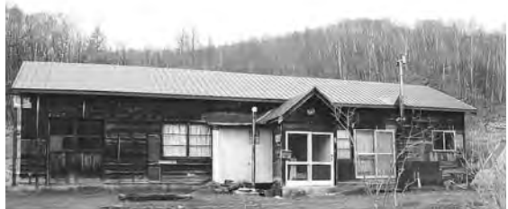
現存する三角兵舎。戦後引揚者住宅となり、現在は道外からの移住者のための住宅として使用されている。（豊田北4線の沢）
