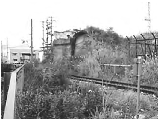
コンクリート製の有川跨線橋橋脚跡
